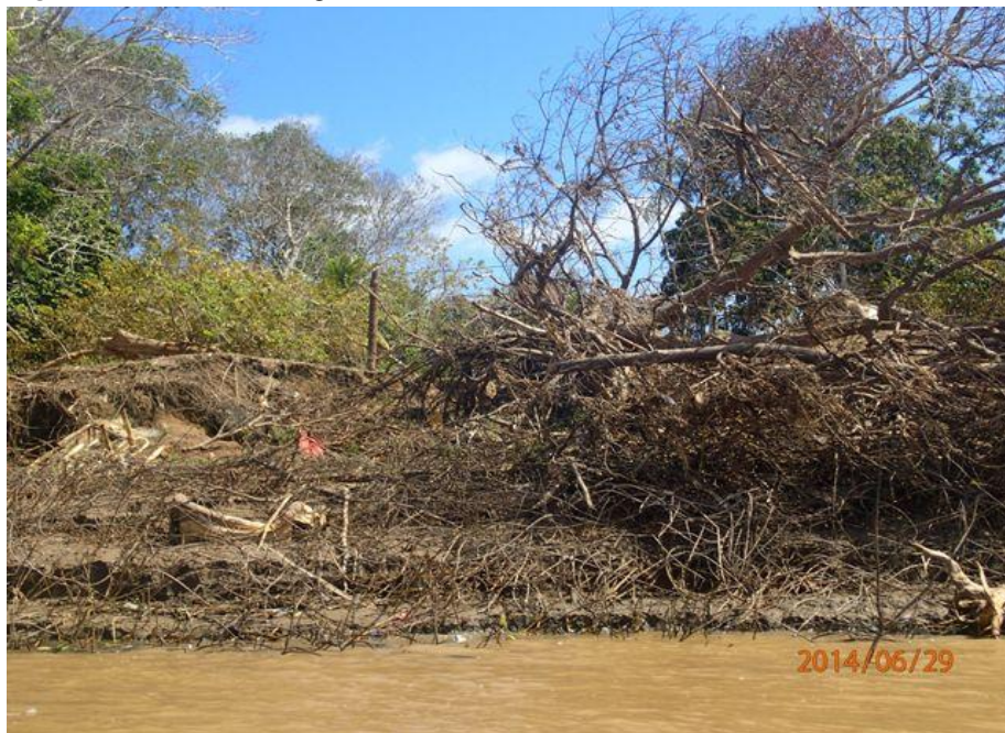
Figura 3: Erosão das margens do rio Madeira, Porto Velho
