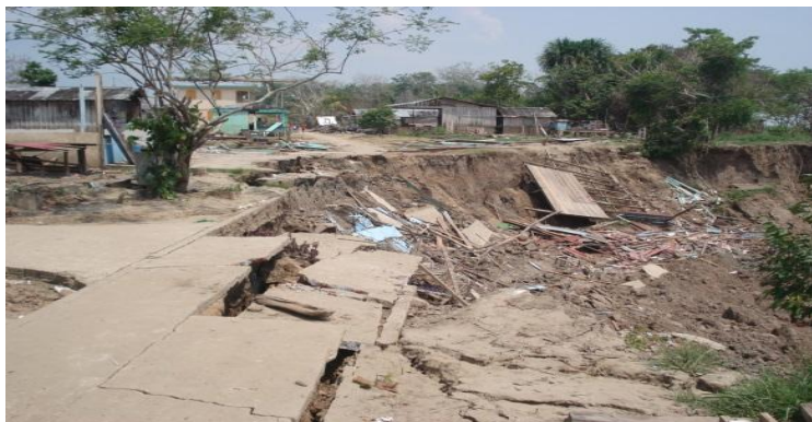
Figura 10: Terraço desmatado submetido à ação erosiva do rio Solimões. Vila Cuia, 2009
